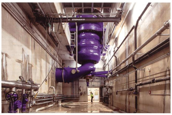
Pompe à 5 étages (500 t/min) de 120 MW de la nouvelle centrale FMHL+.
