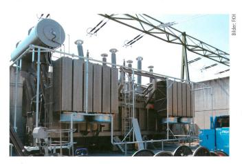
**Bild 5** Neuer 250-MVA-Phasenschieber-Transformator des EWZ im UW Obfelden.
