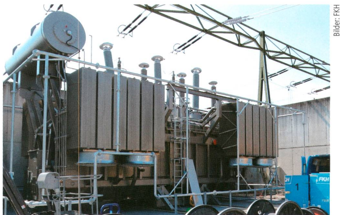
Bild 5 Neuer 250-MVA-Phasenschieber-Transformator des EWZ im UW Obfelden.
