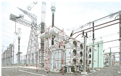
1,2 MV-Transformator am Testgelände im indischen Madhya Pradesh.
