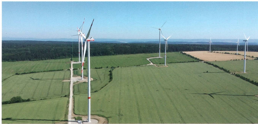
Mit einer Leistung von 23,1 MW gehört der Windpark Westerengel zu den wenigen seiner Grössenordnung, die mit 20 kV an das Stromnetz angebunden sind.
