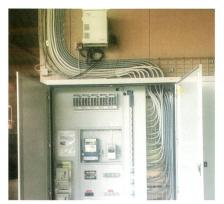
**Bild 3** Spannungshaltung als Dienstleistung mit dem Smart Grid Terminal (oben) am Anschluss der PV-Anlage in Sins (275 kWp).
