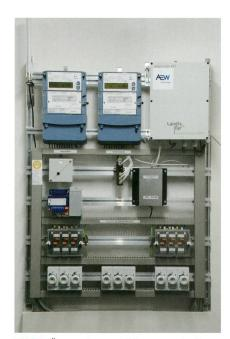
**Bild 2** Überwachung und Steuerung der Transformatorstation Niederwil mit paralleler Energieabrechnung.
