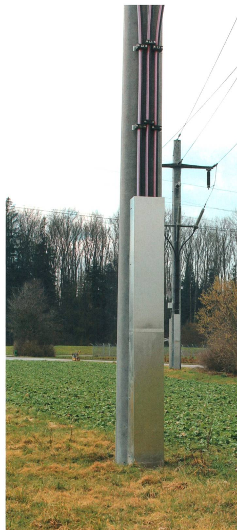
Neues CableMan-Abschirmsystem für Kabelaufstiege für Einhaltung des Immissionsgrenzwertes (100 \mu T) nach NISV in der Höhe von 0,2 bis 2 m.
