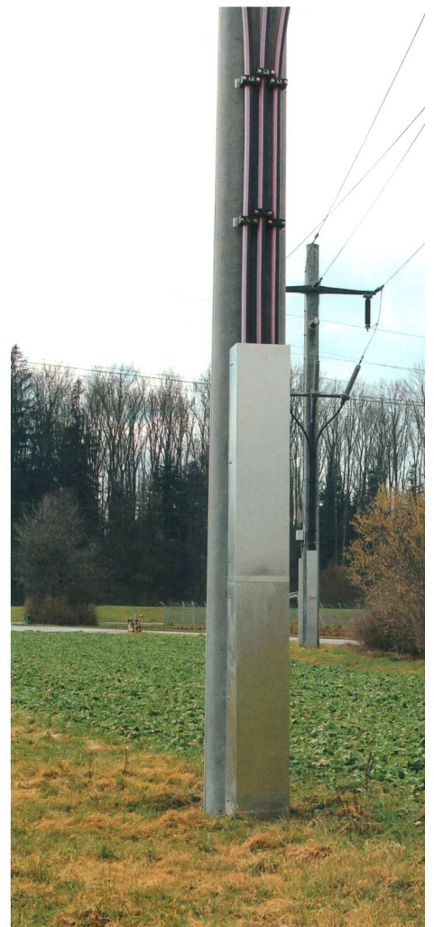
Neues CableMan-Abschirmsystem für Kabelaufstiege für Einhaltung des Immissionsgrenzwertes ( 100 \mu\text{T} ) nach NISV in der Höhe von 0,2 bis 2 m.
