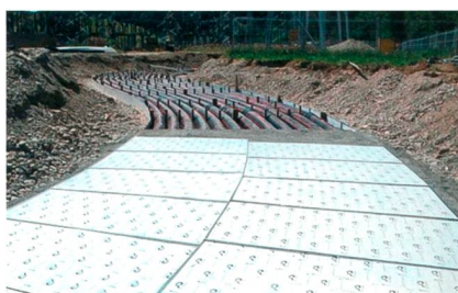
CableMan-Abschirmsystem für Erdkabeltrassen.
