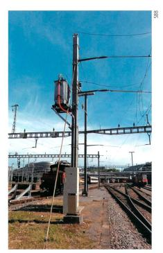
Bild 1 Maststation Weichenheizung.
