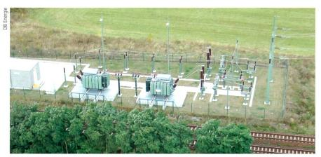
**Bild 4** Blockunterwerk in einfacher H-Schaltung.
