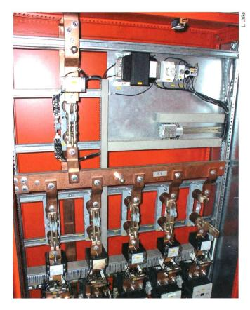
**Bild 2** Sammelschiene 1 AC 1 kV 16,7 Hz DB-Zugheizstation.
