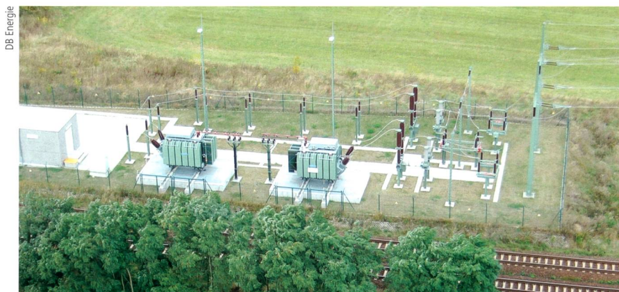
Bild 4 Blockunterwerk in einfacher H-Schaltung.
