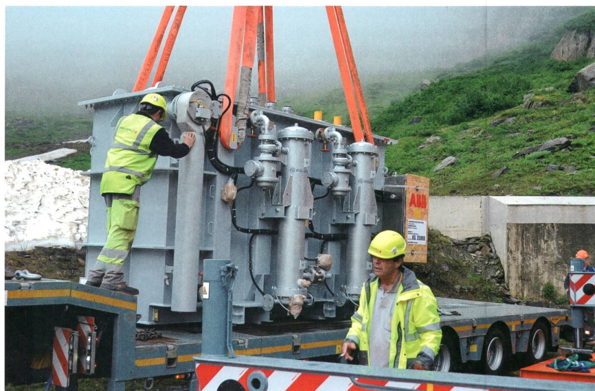
Bild 4 Einbau des neuen, wassergekühlten 20-MVA-Transformators, der sowohl die elektrische Energie der Wasserkraft als auch der Windkraft ins Mittelspannungsnetz einspeist.
