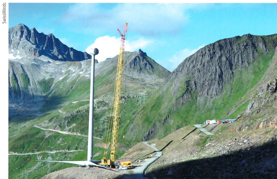
Bild 2 Vorbereitungen am Griespass für die Rotormontage auf einer der neuen Anlagen mit Nabhöhe 131 m. Die engen Platzverhältnisse stellen dabei eine besondere Herausforderung dar. Im Hintergrund ist die Nufenenstrasse sichtbar.
