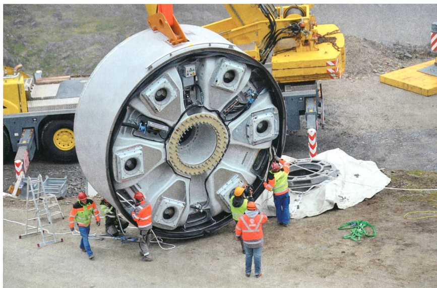
Bild 3 Bei den Griespass-Anlagen werden getriebelose Ringgeneratoren eingesetzt, die wartungsarm sind, da sie kaum Verschleissteile aufweisen und der Getriebeölwechsel entfällt.
