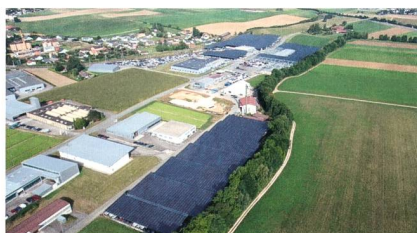
Die PV-Anlage von Courgenay weist eine installierte Leistung von 6,7 MW auf.
