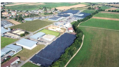
Die PV-Anlage von Courgenay weist eine installierte Leistung von 6,7 MW auf.
