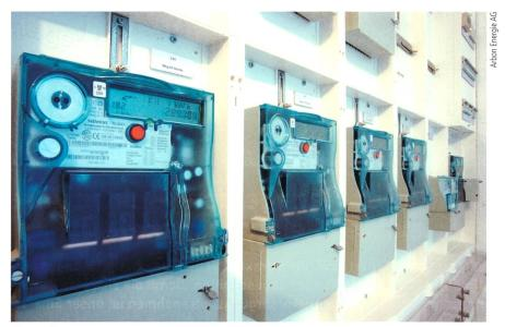
**Figure 1** Les compteurs électriques de la dernière génération (smart meter) saisissent la consommation électrique toutes les 15 minutes. Les mesures permettent de tirer des conclusions sur le foyer correspondant.
