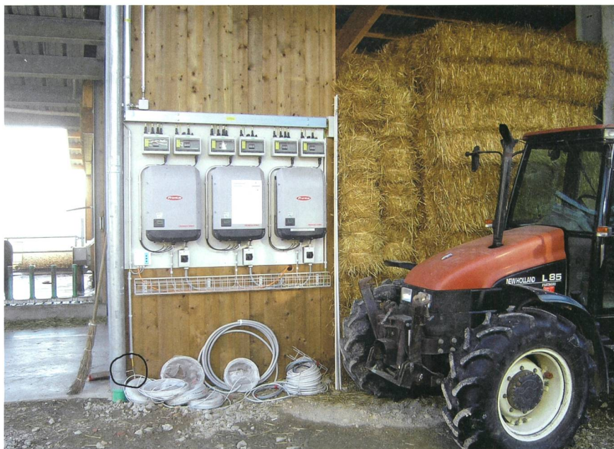
Bild 2 Wechselrichter in einem feuergefährdeten Bereich, Trennungsabstand zu Blitzschutz nicht eingehalten.
