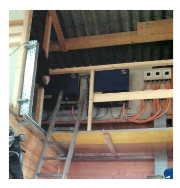
Figura 3 La manutenzione sicura degli inverter non è possibile. L'accesso sicuro non è garantito.
