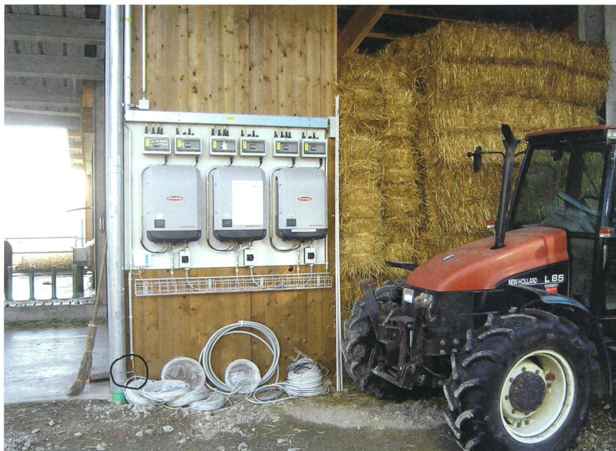
Figure 2 Onduleurs dans une zone à risque d'incendie, distance de séparation à la protection parafoudre non respectée.
