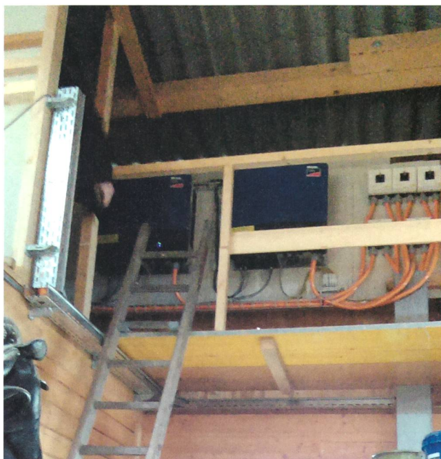
Bild 2 Wechselrichter in einem feuergefährdeten Bereich, Trennungsabstand zu Blitzschutz nicht eingehalten.
