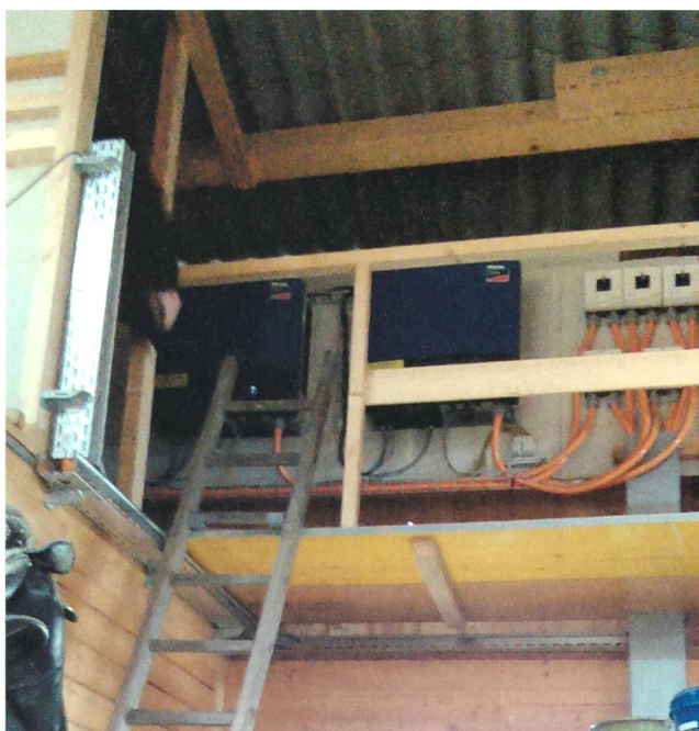
Figure 2 Onduleurs dans une zone à risque d'incendie, distance de séparation à la protection parafoudre non respectée.
