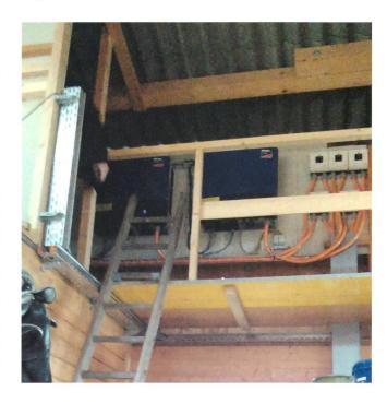
**Bild 3** Keine sichere Wartung der Wechselrichter möglich. Sicherer Zugang ist nicht gewährleistet.
