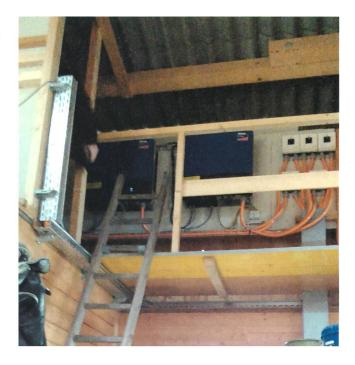
Figure 3 Aucune maintenance sécurisée des onduleurs possible; accès sécurisé non garanti.
