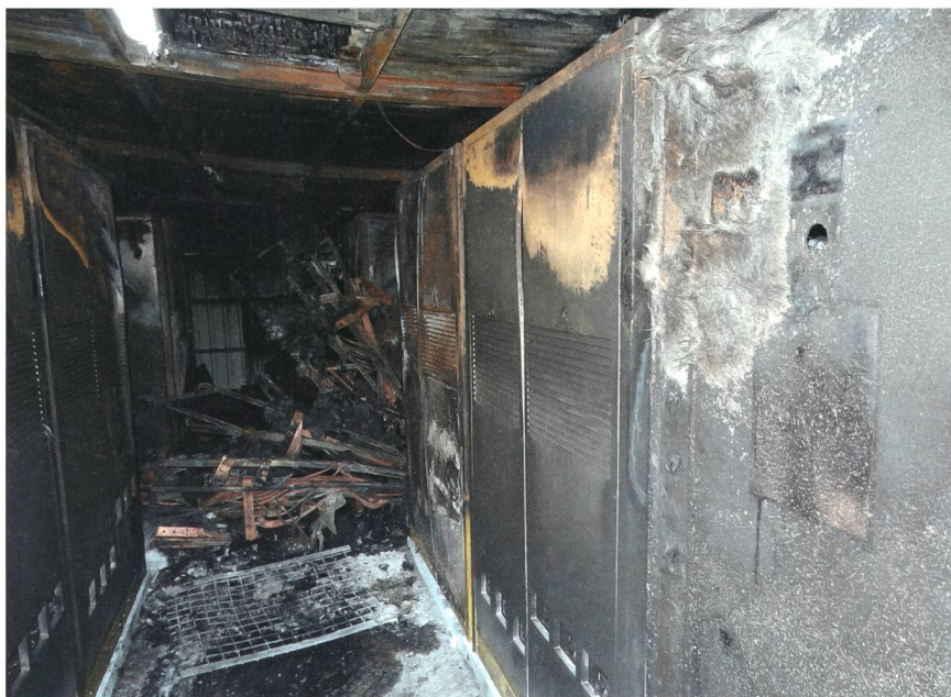
Figura 5 Locale di esercizio adibito a servizi elettrici con inverter ed apparecchiature assiemate di manovra distrutto da un incendio.
