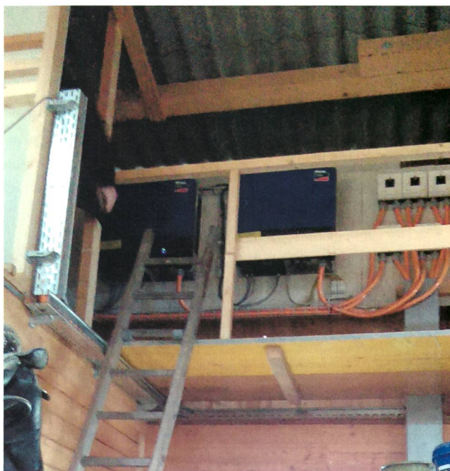
Figura 2 Inverter in zona a rischio d'incendio, distanza di separazione dall'impianto di protezione contro i fulmini non rispettata
