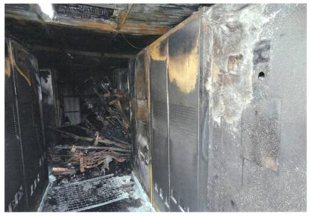
**Figure 5** Local électrique contenant des onduleurs et divers appareillages de commutation détruit par un incendie.
