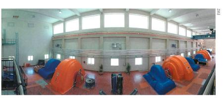
Ein Blick in das Maschinenhaus zeigt die drei revidierten Generatoren, die zuverlässig von einer neuen Löschanlage geschützt werden.
