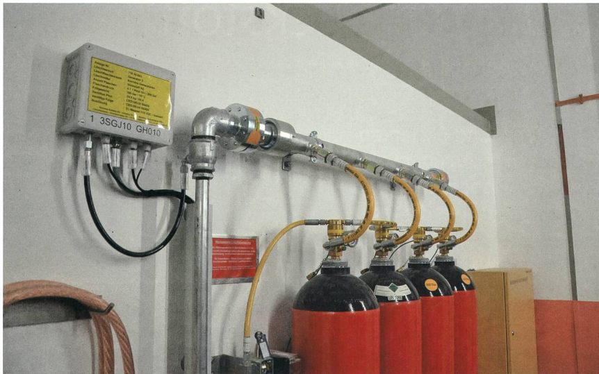
Die Hochdruckstahlflaschen lagern den Stickstoff bei 300 bar.
