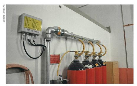
Die Hochdruckstahlflaschen lagern den Stickstoff bei 300 bar.
