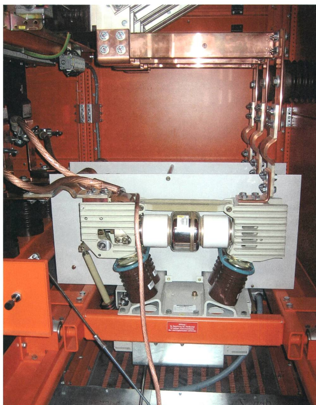
Das Herzstück des Kraftwerks: Der Vakuum-Generatorschalter mit 50 kA.
