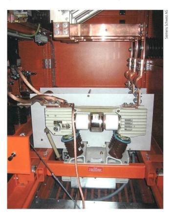
Das Herzstück des Kraftwerks: Der Vakuum-Generatorschalter mit 50 kA.
