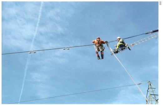
Montage von Schwingungsdämpfern an einer Freileitung.
