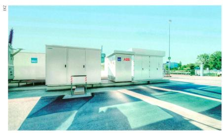
Bild 2 Batteriespeicher der EKZ zum Betrieb eines Bürogebäudes als Microgrid.
