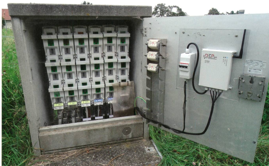
Figure 2 Armoire de distribution avec un module GridEye.
