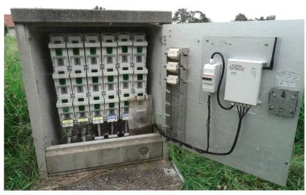
Figure 2 Armoire de distribution avec un module GridEye.
