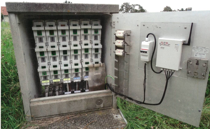
Bild 2 Verteilkasten mit einem GridEye-Modul.
