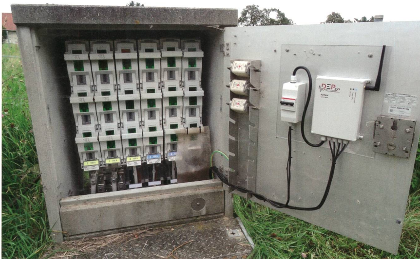
Bild 2 Verteilkasten mit einem GridEye-Modul.
