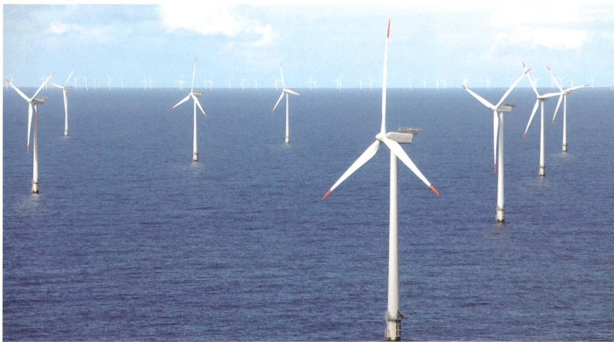
Der Windpark Hornsea Project One wird mit einem 220-kV-Kabelsystem mit dem Festland verbunden.
