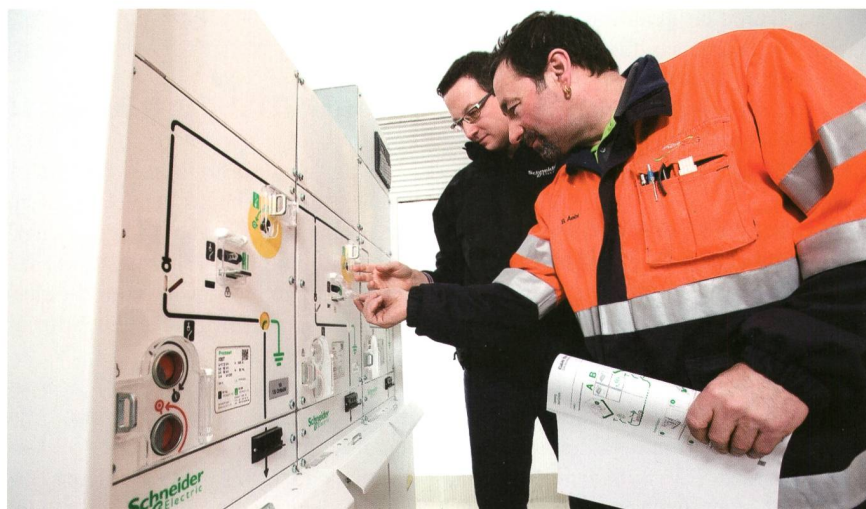
Die letzten Handgriffe vor der Inbetriebnahme der schweizweit ersten MS-Anlage mit komplett erdgeschirmter Feststoffisolierung.
