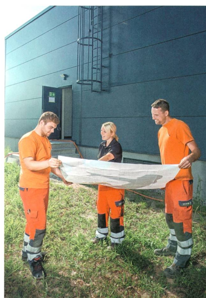
Besprechung der Montagearbeiten vor dem Unterstationsgebäude. Für diese Arbeiten zeichnete die BKW Tochter Arnold AG unter der Leitung von Evelyne Wyss (Mitte), verantwortlich.
