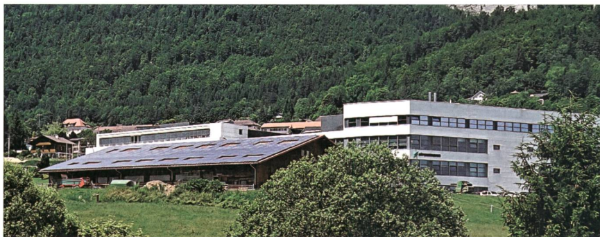
Die PV-Anlage in Villeret mit einer Leistung von 143 kWp machte eine Netzverstärkung erforderlich. Foto: La Goule
