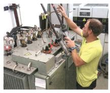
Dank der Montage eines regelbaren Ortsnetztransformators (RONT) musste keine zweite Trafostation gebaut werden. Foto: La Goule
