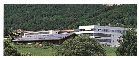
Die PV-Anlage in Villeret mit einer Leistung von 143 kWp machte eine Netzverstärkung erforderlich. Foto: La Goule
