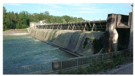
**Bild 4** Unterwasserkraftwerk Lechstaustufe 15 bei Landsberg am Lech, Inbetriebnahme 1943, 6 Maschinensätze, Ausbauleistung 7,8 MW bei 8,0 m Fallhöhe. [2]
