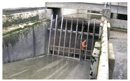
**Bild 5** Wasserkraftanlage am Mühlbach in Landsberg am Lech, Segmentbogen-Rechenreinigungsanlage mit vorgeschaltetem Grobrechen.
