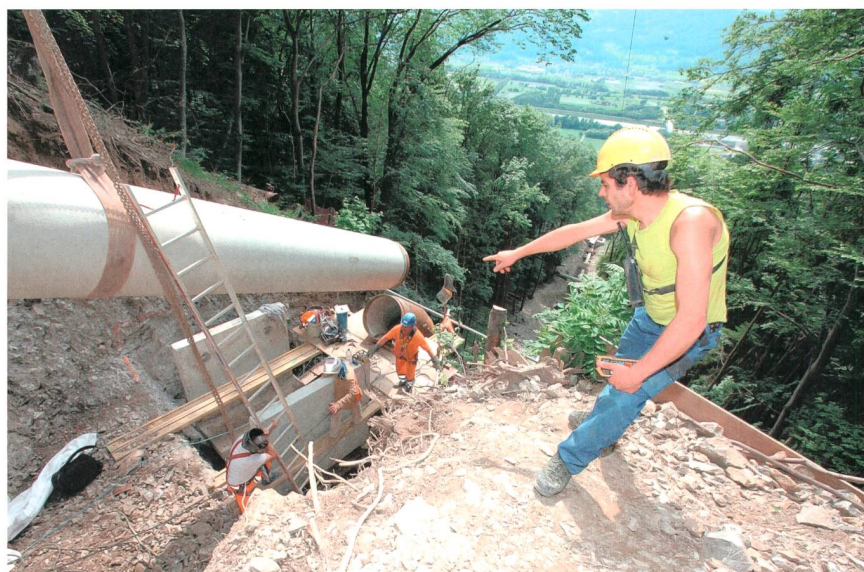
Druckleitungsverlegung am Hang.
