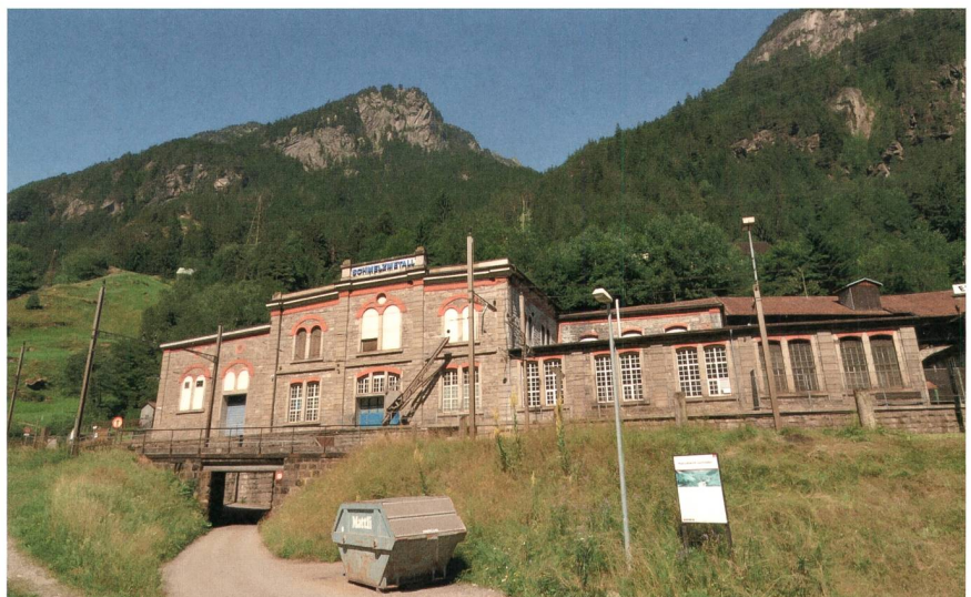
Bild 1 Kraftwerksgebäude in Gurtellen.
