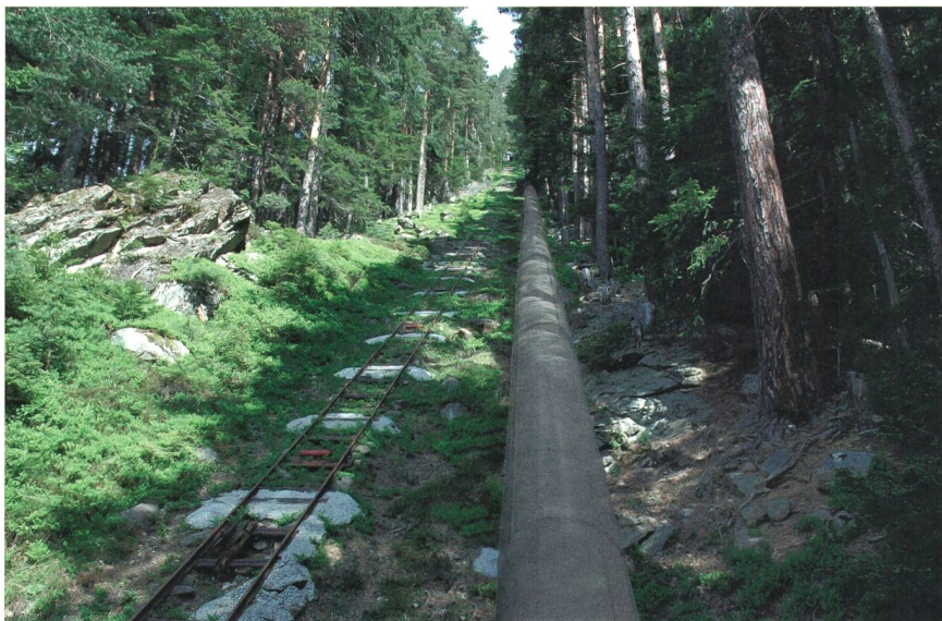
Bild 2 Die zu ersetzende Druckleitung.
