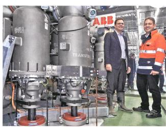
Pascal Müller, Gesamtleiter des neuen Unterwerks Oerlikon (links) und Reto Aeschbach, Verkaufsleiter bei der Pfisterer Sefag AG (rechts) freuen sich über die gelungene Fusion umweltfreundlicher Technologien: trocken isolierte HV-Connex-Kabelanschlüsse von Pfisterer im Einsatz an ökogasisolierter HV-Schaltanlage von ABB.
