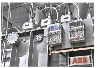
Die neuen MV-Connex-Transformatoren-Anschlussteile von Pfisterer (obere Bildmitte) für bis zu 2200 A respektive 3150 A je nach Anschlussart und bis zu 52 kV ermöglichen den hochkompakten Mehrfach-Anschluss von vertikal geführten MV-Kabeln – hier im Einsatz mit Erdtrennerkästen für die effiziente Schirmbehandlung und DSA-i3-Dauerspannungsanzeige-Geräten von Pfisterer.
