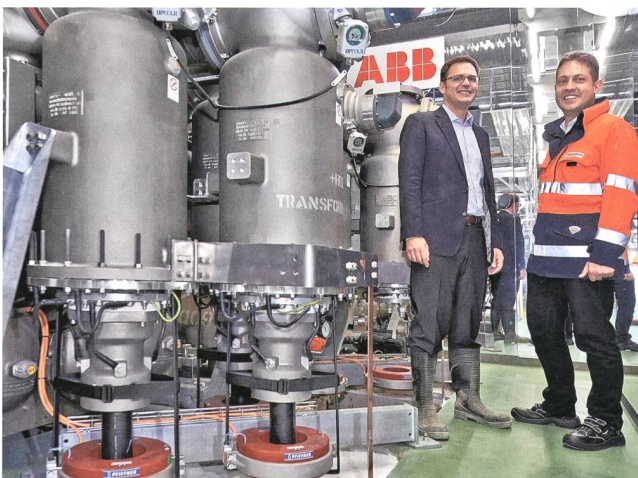
Pascal Müller, Gesamtleiter des neuen Unterwerks Oerlikon (links) und Reto Aeschbach, Verkaufsleiter bei der Pfisterer Sefag AG (rechts) freuen sich über die gelungene Fusion umweltfreundlicher Technologien: trocken isolierte HV-Connex-Kabelanschlüsse von Pfisterer im Einsatz an ökogasisolierter HV-Schaltanlage von ABB.
