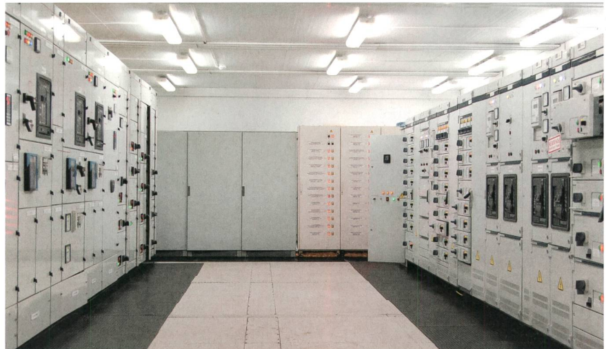
MS-Schaltanlage.
