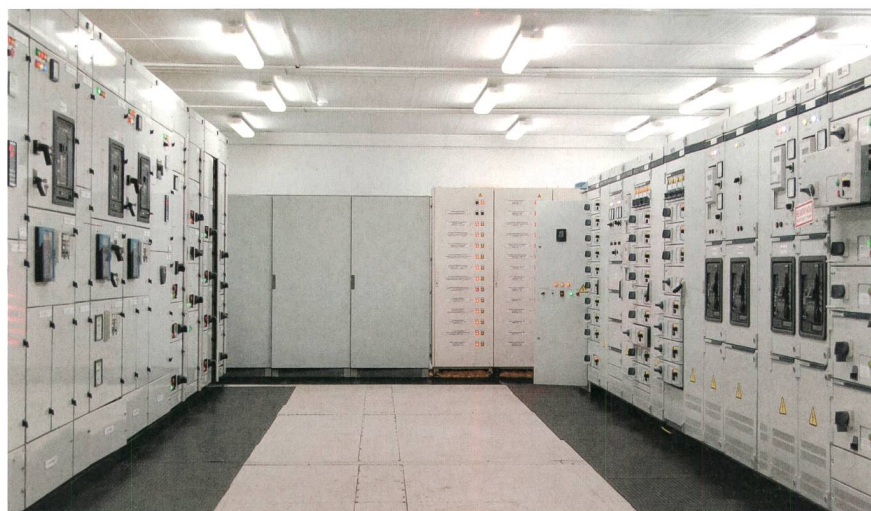
MS-Schaltanlage.
