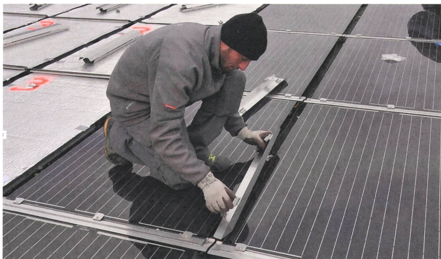
Das Dachelement TCR (Triactive Core Roof) der Firma Designergy SA vereint Wärmedämmung, Wasserdichtigkeit und Stromerzeugung durch Fotovoltaik.
