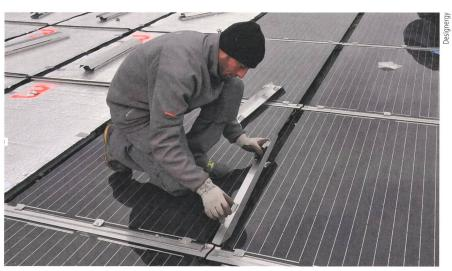
Das Dachelement TCR (Triactive Core Roof) der Firma Designergy SA vereint Wärmedämmung, Wasserdichtigkeit und Stromerzeugung durch Fotovoltaik.
