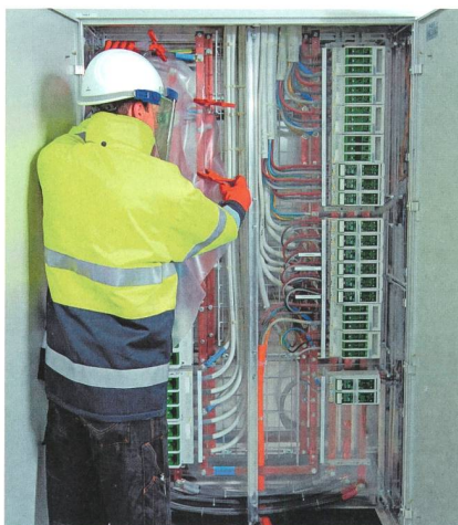
Arbeiten unter Spannung.
