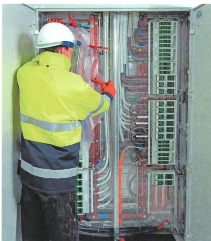
Arbeiten unter Spannung.
