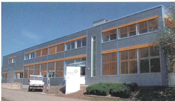
Le laboratoire de Rossens, Electrosuisse Romandie, ainsi que l'Inspection fédérale des installations à courant fort (ESTI) sont regroupés sous un même toit depuis fin 2014.
