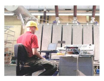
**Bild 1** Beispielapplikation: Teilentladungsdiagnose am Transformator.
