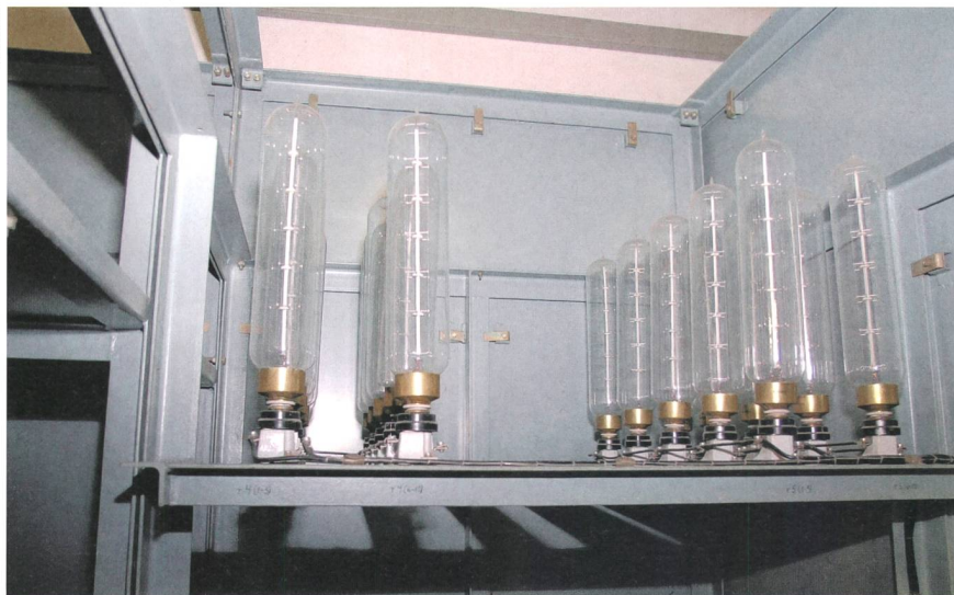
Bild 5 Fe-H-Widerstände, Büto-W-Schutz.
