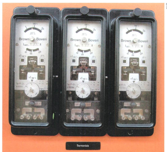
Bild 4 Thermisches Überstromrelais ST, BBC.
