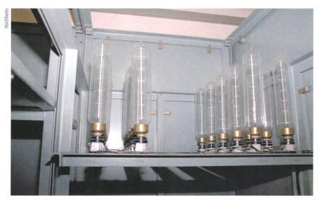
Bild 5 Fe-H-Widerstände, Bütow-Schutz.
