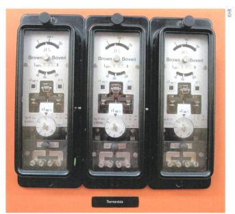
**Bild 4** Thermisches Überstromrelais ST, BBC.
