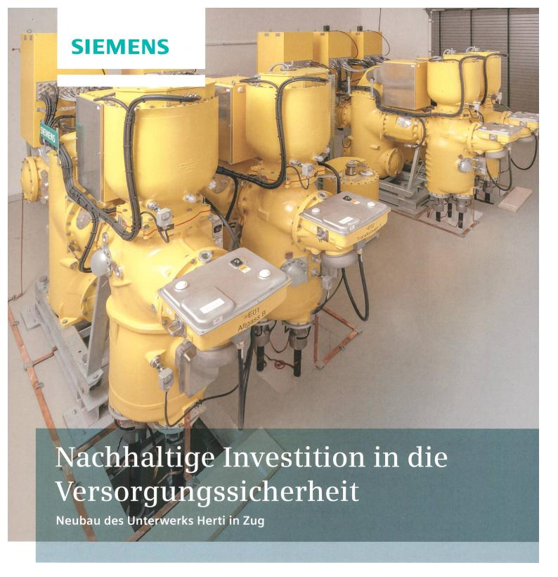
Um die Versorgungssicherheit der Stromzufuhr in der Region Zug zu gewährleisten, wurde das Unterwerk Herti der Wasserwerke Zug AG (WWZ) neu gebaut. Dieses bildet die Schnittstelle zwischen den überregionalen und den regionalen Leitungsebenen. Siemens lieferte die gesamte elektrotechnische Ausrüstung für die Stationsautomatisierung, die 110 kV-GIS-Schaltanlage, die 16 kV-MS-Schalt-/Rundsteuerungsanlage sowie die Eigenbedarfsversorgung. Die integrierte, gasisolierte Schaltanlage (GIS) macht die
