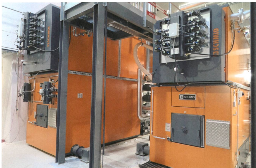
Zwei Holzkessel mit 750 kW sowie 1500 kW Kesselleistung.
