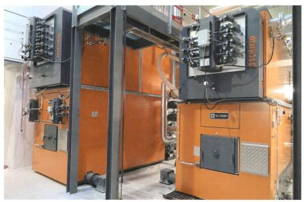
Zwei Holzkessel mit 750 kW sowie 1500 kW Kesselleistung.
