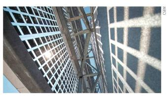
Les modules photovoltaïques sont montés sur une structure métallique détachée de la façade du bâtiment.
