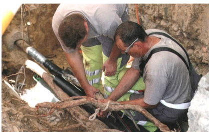
Netzelektriker bei Reparaturarbeiten an einem 13-kV-Stromkabel.
