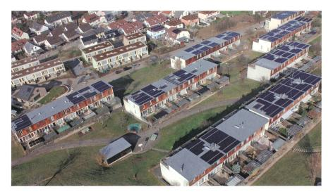
Insgesamt 33 Solarstromanlagen wurden 2012 auf der Wohnüberbauung Eich installiert und in Betrieb genommen. Seither produzieren sie zusammen auf einer Fläche von 1334 m² jährlich rund 131000 kWh Strom. In den Sommermonaten speisen die Anlagen zu Spitzenzeiten eine deutlich höhere Leistung ein, als die Überbauung zur selben Zeit selbst verbraucht und treiben so die Netzspannung über die gesetzlichen Normwerte.
