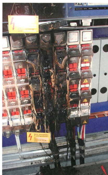
Schaden durch Kurzschluss beim Arbeiten; Person schwer verletzt.
