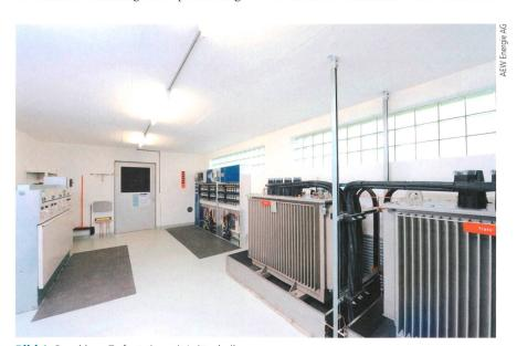
**Bild 1** Begehbare Trafostation mit Leittechnik.
