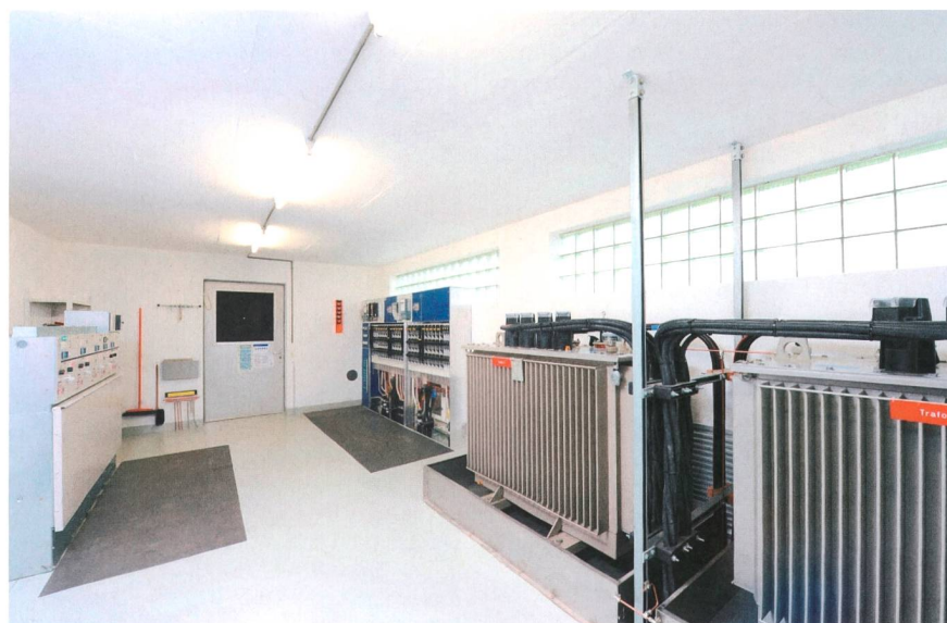
Bild 1 Begehbare Trafostation mit Leittechnik.
