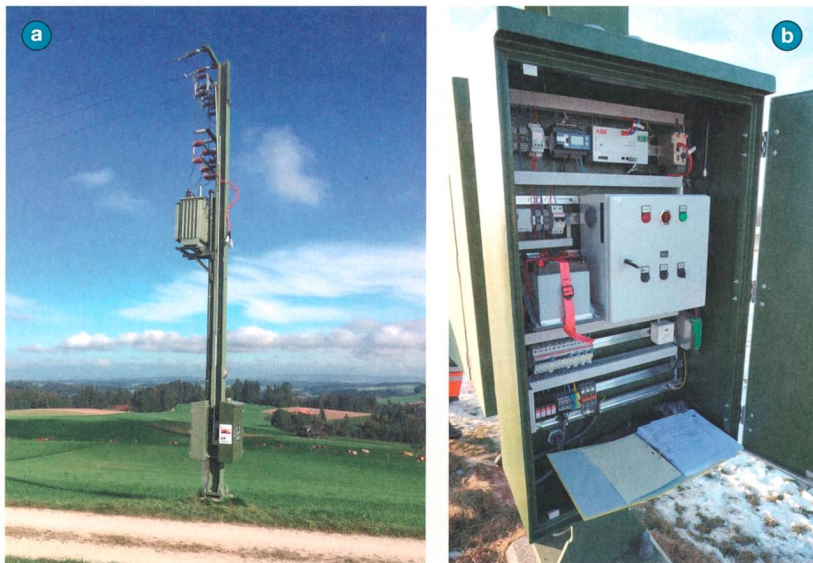
Bild 3 Regelbarer Ortsnetztransformator als Maststation.
