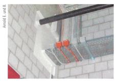
**Bild 8** Beispiel grossflächige Durchführung von Metallkanal durch Brandschottung.
