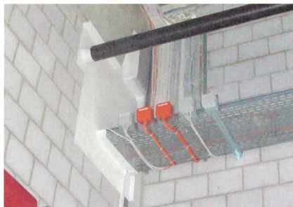
Bild 8 Beispiel grossflächige Durchführung von Metallkanal durch Brandschottung.
