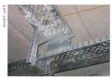
**Bild 6** Beispiel Trassen mit grossflächiger Durchgängigkeit (4.4.4.Z1) als Potenzialausgleichsleiter mit Anschluss an Bewehrung (5.4.3).
