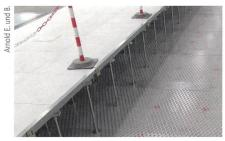
**Bild 4** Beispiel einer engmaschigen Potenzialausgleichsanlage (SRPP; Systembezugspotenzialebene nach SN EN 50310) unter Einbezug aller Konstruktionen.
