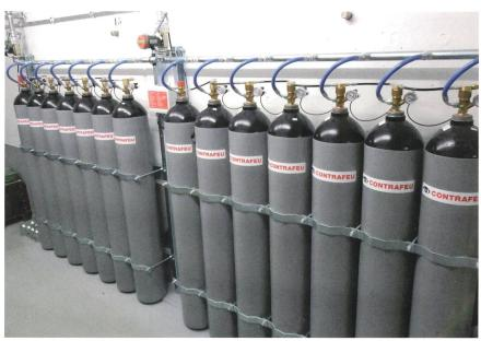
Stickstoffflaschenbatterie für zwei Löschbereiche mit mechanischer Blockiervorrichtung.
