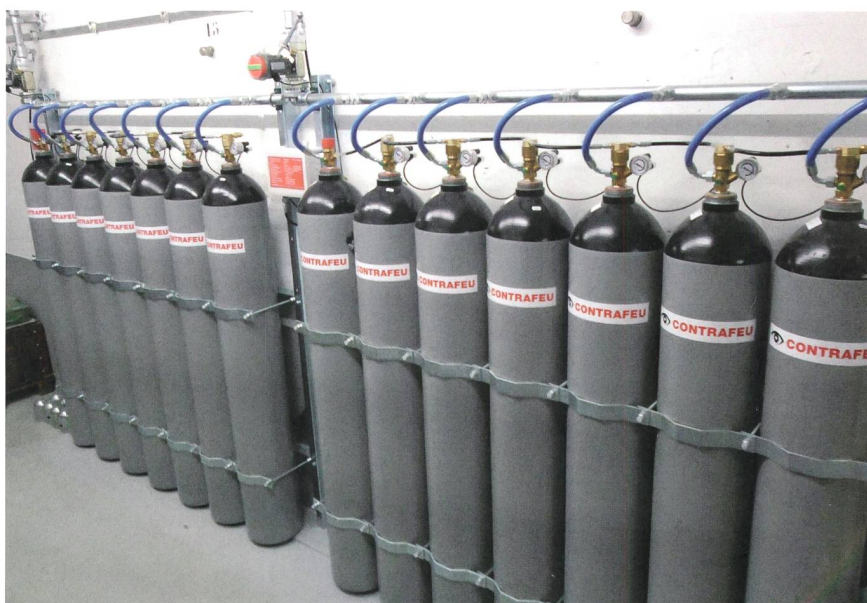
Stickstoffflaschenbatterie für zwei Löschbereiche mit mechanischer Blockiervorrichtung.
