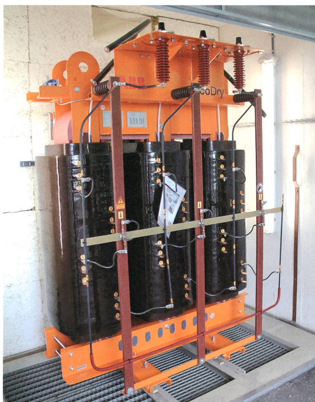
Bild 7 Amorpher EcoDry Trockentransformator, im Unterwerk Fällanden seit 2010.
