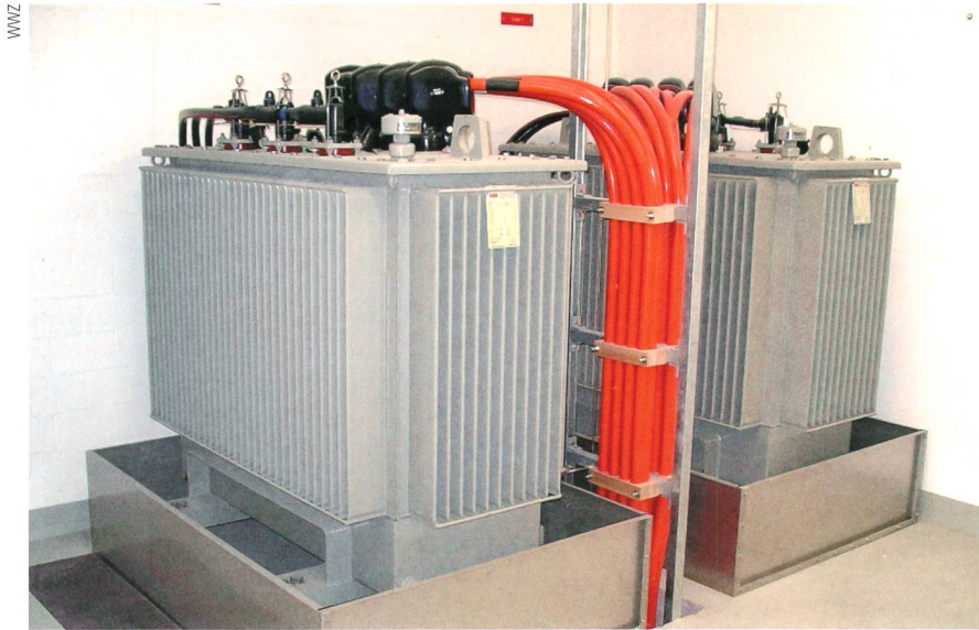
Bild 4 Ölfüllte Verteiltransformatoren in Trafostation.
