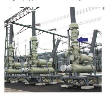
**Bild 5** Beispiel einer Installation mit NCIT. Der Pfeil zeigt auf den Sensor, der die Abtastwerte an den Zähler und die Schutzeinrichtung sendet.
