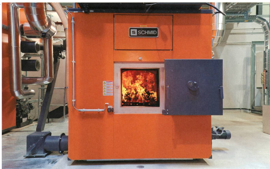
Einer der zwei Kessel der neuen Holzschnitzelheizung.
