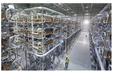
Die HVDC-Plus-Technik basiert auf selbstgeführten Stromrichtern (VSC) in modularer Multilevel-Converter-Bauweise (MMC), die den Wechselstrom in Gleichstrom – und umgekehrt – wandelt.
