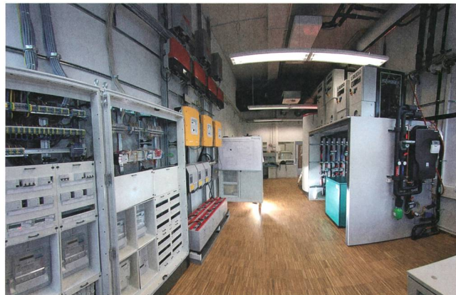
Blick ins SmartEnergy-Lab des Fraunhofer ISE. Die gelben Kästen beherbergen die dezentralen Agenten.
