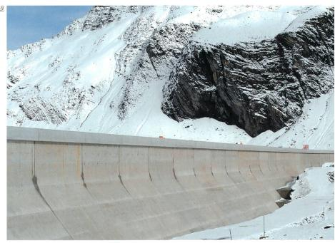
**Bild 1** Die 2014 fertiggestellte Gewichtsstaumauer am Muttsee ist mit rund 1 km Länge die längste Staumauer der Schweiz.
