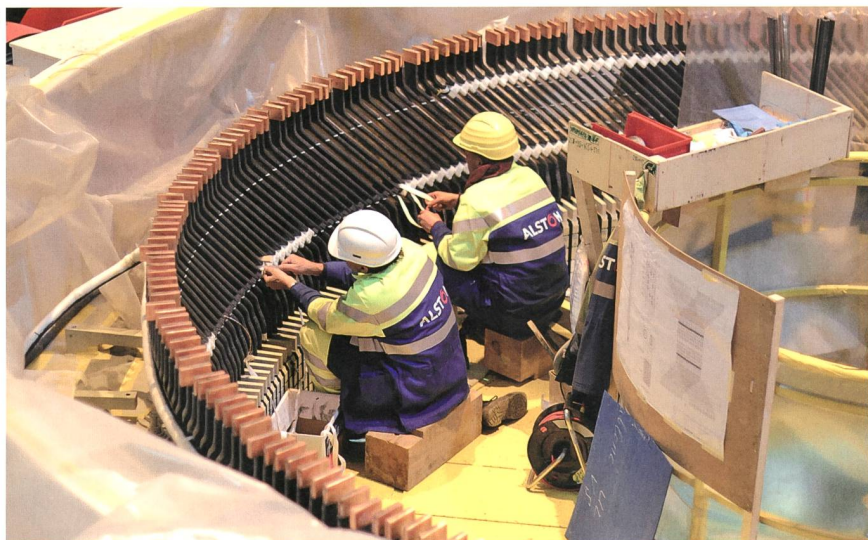
Bild 2 Bau des Stators einer der vier 250-MW-Maschinen in der Kaverne.
