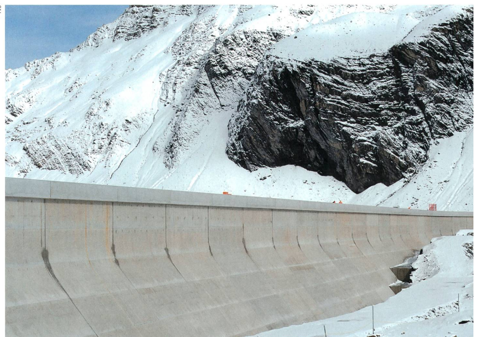
Bild 1 Die 2014 fertiggestellte Gewichtsstaumauer am Muttsee ist mit rund 1 km Länge die längste Staumauer der Schweiz.
