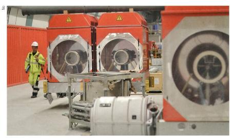
**Bild 4** Generatorschalter im Montagebereich der Maschinenkaverne. Die Schalter werden bei ABB in Oerlikon hergestellt.
