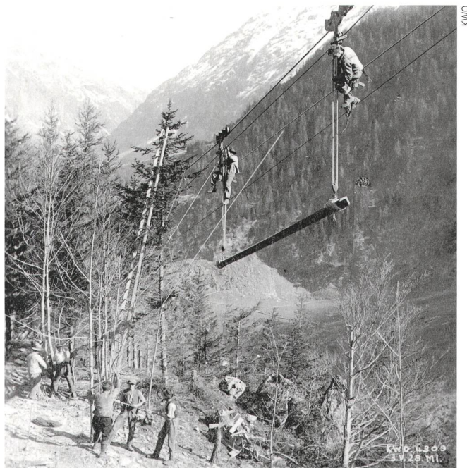
Bild 1 Die Stromversorger trieben die technische und wirtschaftliche Entwicklung mit ihrem Engagement voran. Im Bild: Luftkabelbahntransport beim Bau des ersten Kraftwerks Handeck am Grimsel 1928.
