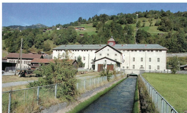
Bild 3 Das im Kraftwerk Küblis (Bild) turbinierete Wasser wird nicht mehr in den Talfluss Landquart geleitet, sondern direkt in einem über 16 Kilometer langen Druckstollen talwärts geführt.
