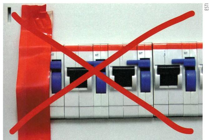
**Bild 2** Mit Klebeband abkleben, reicht nicht für Schutz gegen Wiedereinschalten.
