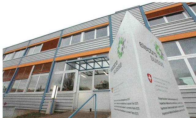
Betriebsgebäude am Standort Rossens.
