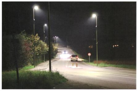
Bild 1 Anlage mit Radarsensoren und LED-Leuchten in Regensdorf.
