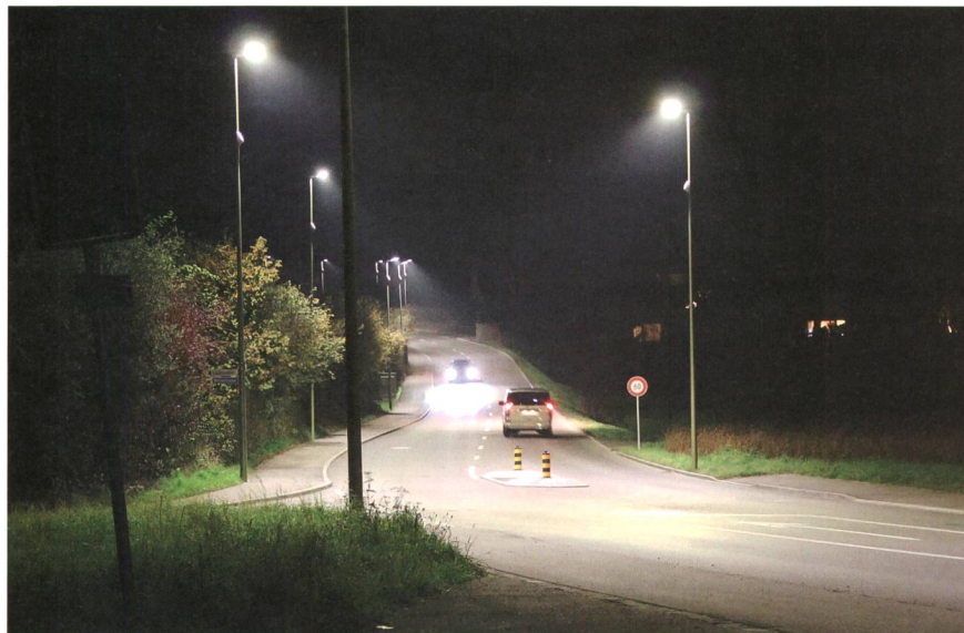
Bild 1 Anlage mit Radarsensoren und LED-Leuchten in Regensdorf.
