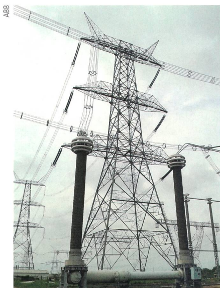
1,2-MV-Schaltanlage.
