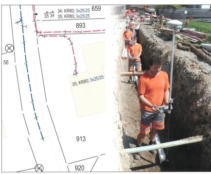
Bild 1 Datenaufnahme mit GPS und Darstellung im GIS.
