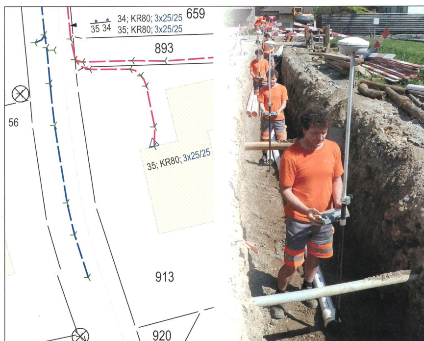
Bild 1 Datenaufnahme mit GPS und Darstellung im GIS.
