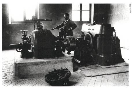
Bild 3 EW Thun mit Gleichstrommaschine von Brown / MFO (1892).
